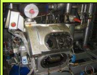
Démontage compresseur à pistons
