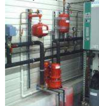
Module hydraulique chauffage
